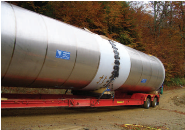
Доставка на биофилтър, готов за монтаж
